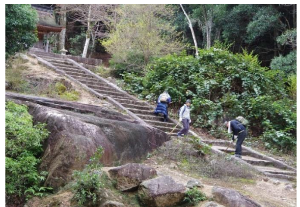
第2班清掃作業（滝宮神社付近）
