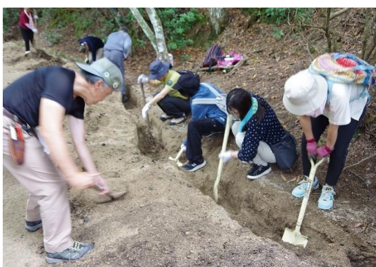
側溝土砂除去作業
