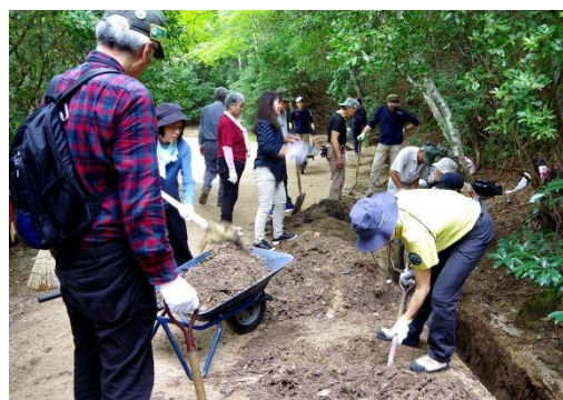
側溝土砂除去作業
