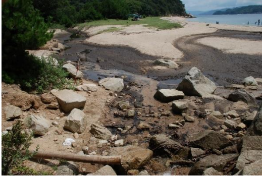
(水路の海への開口状況)
