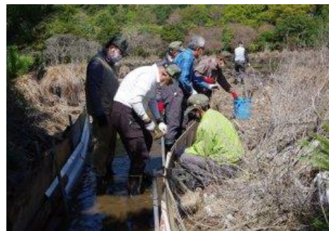
パネルの固定
