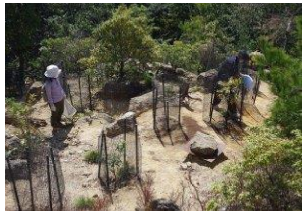
鹿除け防護柵の設置
