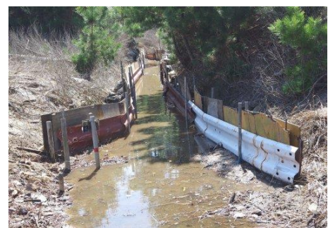
補修終了(入浜池側)
